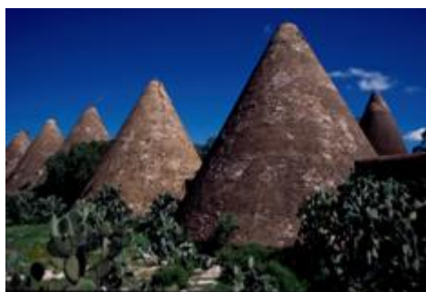
Silos de Santa Mónica, hacienda de San Juan de Trancoso, México
