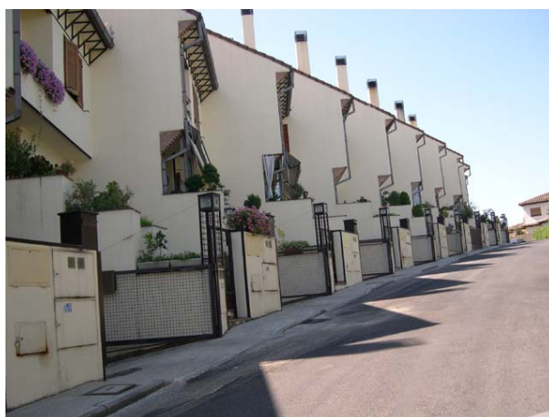
Chalets adosados en la ciudad de Tres Cantos (Madrid)
