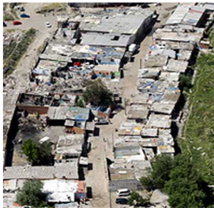
Asentamiento chabolista de las Barranquillas (Madrid)
