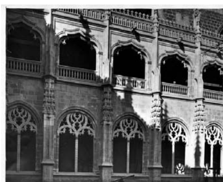
Arcos conopiales y carpaneles, propios del estilo isabelino
